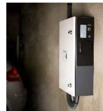
Coffret électrique incluant la borne de recharge,
