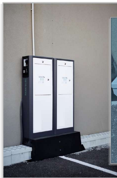
Paire de « totems » posé sur un caniveau sur dalle béton
